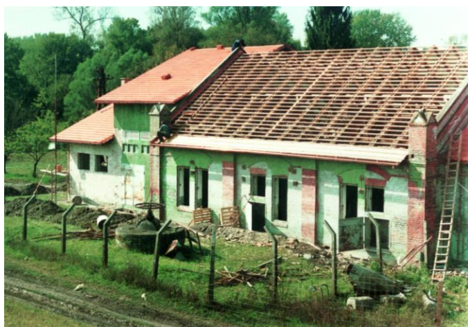
5.2: Obnova crpne stanice »Zlatna greda«, 2000. god.
