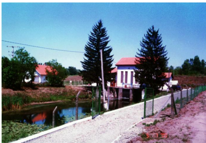
5.10: Obnovljena crpna stanica »Tikveš«, 2000. god.
