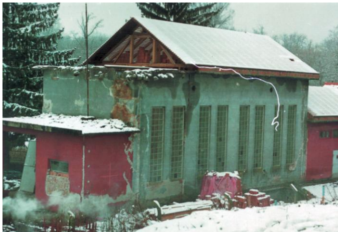
5.9: Početak obnove crpne stanice »Tikveš«, 1999. god.
