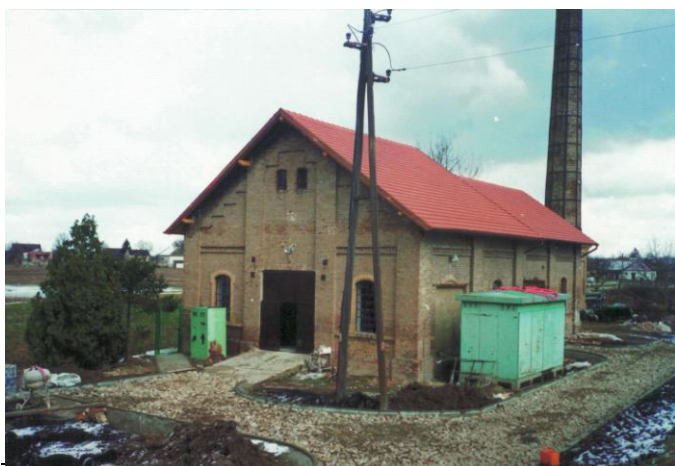
5.5: Obnovljena crpna stanica »Draž«, 2000.
