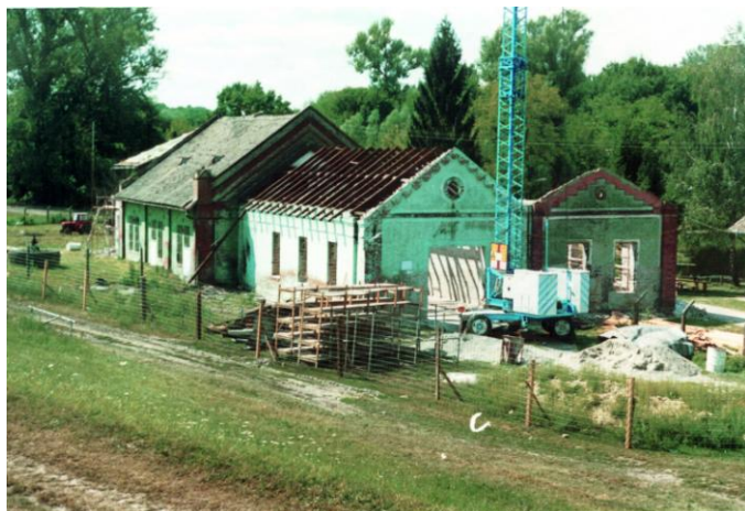
5.1: Crpna stanica »Zlatna greda«, početak obnove 1999. god.
