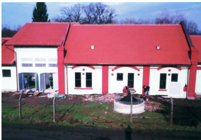
5.3: Obnovljena crpna stanica »Zlatna greda«, 2000. god.
