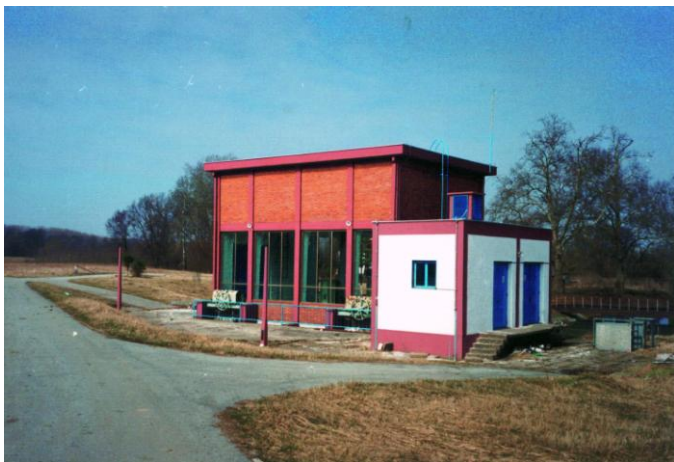
5.7: Obnovljena crpna stanica »Bakanka«, 2000. god.
