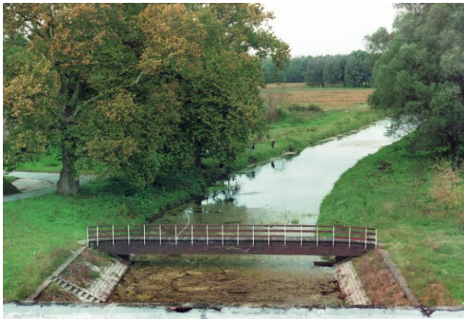
5.6: Dovodni kanal crpne stanice »Bakanka«, 2000. god.
