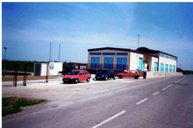
5.15: Obnovljena crpna stanica »Paulin dvor«, 2002. god.
